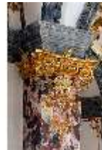
WüHK.II, Wandpfeiler (Detail), DI011821, BSV-
